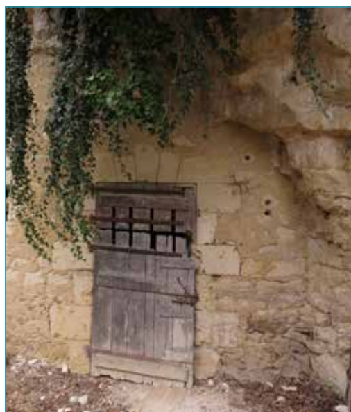
Illustration 3.11 : Fermeture hermétique interdisant la ventilation d'une cavité, Le Vieil-Baugé (49) [crédit Cerema Ouest, 2014]
