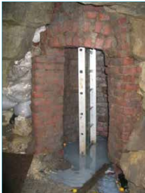
Illustration 1.34 : Nappe phréatique affleurant au plancher d'une carrière souterraine, sa couleur bleutée est à mettre en relation avec une pollution, Nord [crédit INERIS, sd]
