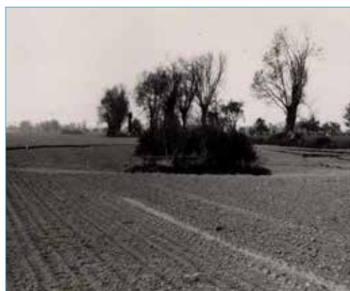
Illustration 1.22 : Effondrement généralisé à l'aplomb d'une marnière, Haute-Normandie [crédit Cerema Normandie-Centre, années 1980]
